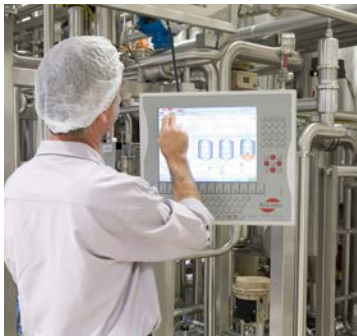
Kontrolle: Jeder Schritt wird überwacht
