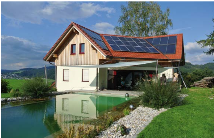
Effiziente Kombination: Solarthermie und Photovoltaik
