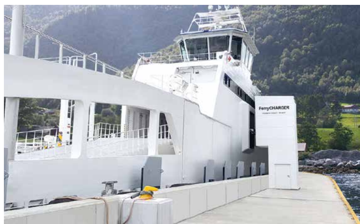
Ein FerryCharger von STEMMANN-TECHNIK im Einsatz, beim Anlegen, Be- und Entladen werden batteriebetriebene Fähren automatisch geladen
