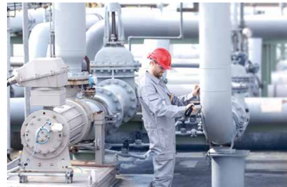
Korrosionsprüfung mit dem SONOWALL 70 Wanddickenmessgerät in der TOTAL Raffinerie Leuna
