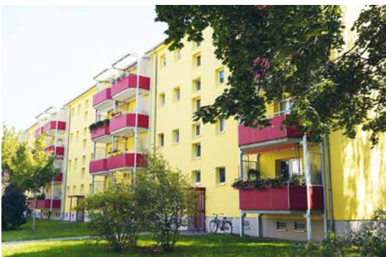
Ansprechend saniert präsentiert sich das Wohngebäude in Ludwigsfelde West I an der Salvador-Allende-Straße
