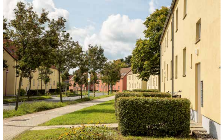
Die um 1940 entstandenen Wohnobjekte der ehemaligen Daimler-Benz-Werksiedlung wurden umfangreich saniert und bieten heute rund 370 Ein- bis Vierzimmerwohnungen
