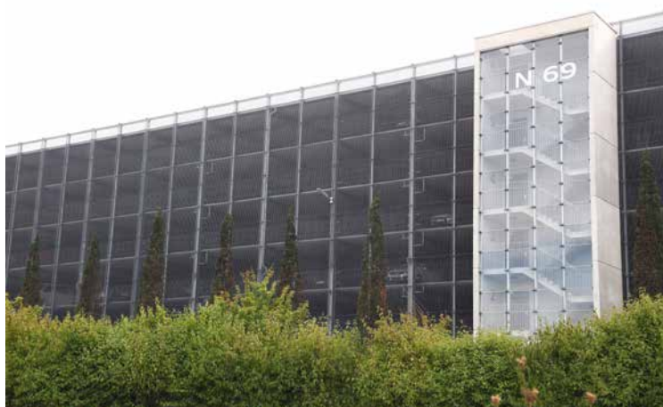
Das werkseigene Parkhaus von AUDI in Ingolstadt ist komplett mit Staco Pressrosten aus feuerverzinktem Stahl verkleidet, eine in Form und Funktion ansprechende Lösung
