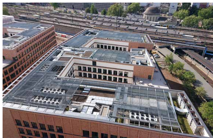
Für die Messe Köln, einen Gebäudekomplex von 135.000 m 2 , hat Staco eine Dachfassade aus Gitterrosten mit fluchtenden Trag- und Querstäben gefertigt
