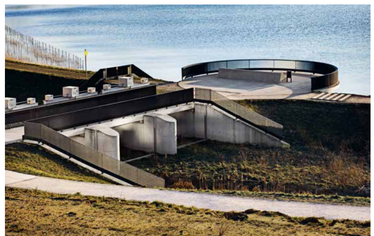
Architektonische Gitterroste mit Geländerfunktion sowie Baumschutzroste von Staco zieren das moderne Areal um den Dortmunder Phoenix-See und tragen zum positiven Stadtbild bei
