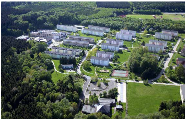
Hochschule der Polizei im Energieeffizienznetz Flughafen Hahn: Hier wurde das bestehende Fernwärmenetz erneuert. Allein die Wärmekosten ließen sich so um 35% reduzieren
