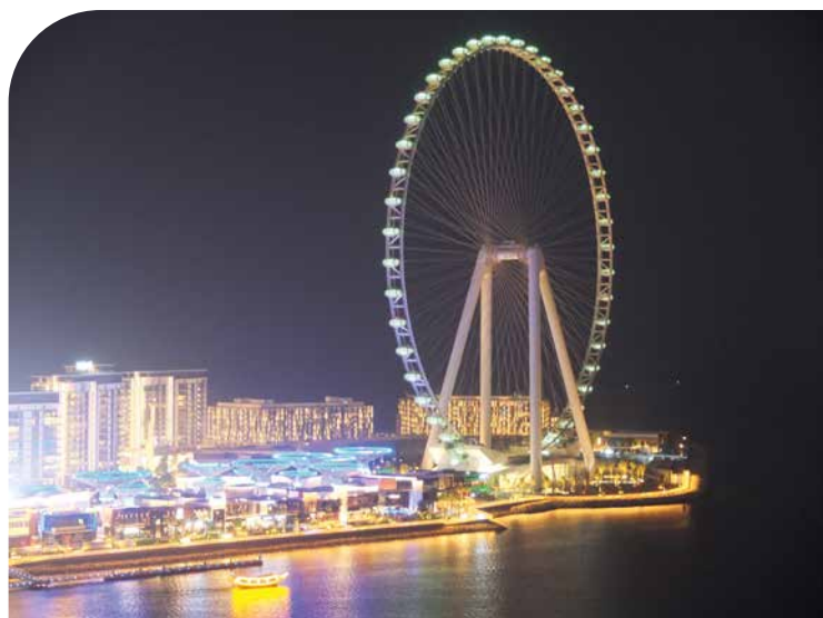
Das Ain Dubai ist das größte und höchste Aussichtsrad der Welt und für VAHLE ein Leuchtturmprojekt
