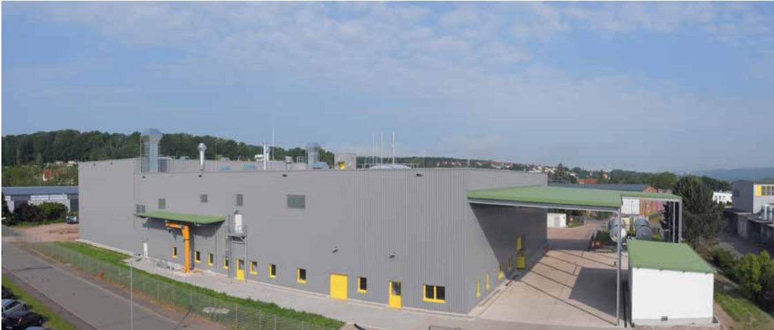
In der neuen Produktionshalle will TRIBO seine eigenen Hartmetall-Pulvermischungen fertigen
