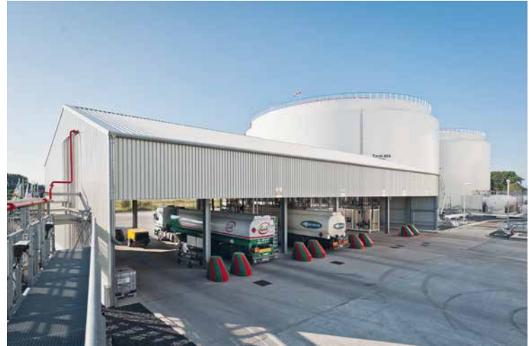
Befüllanlage für Tankfahrzeuge
