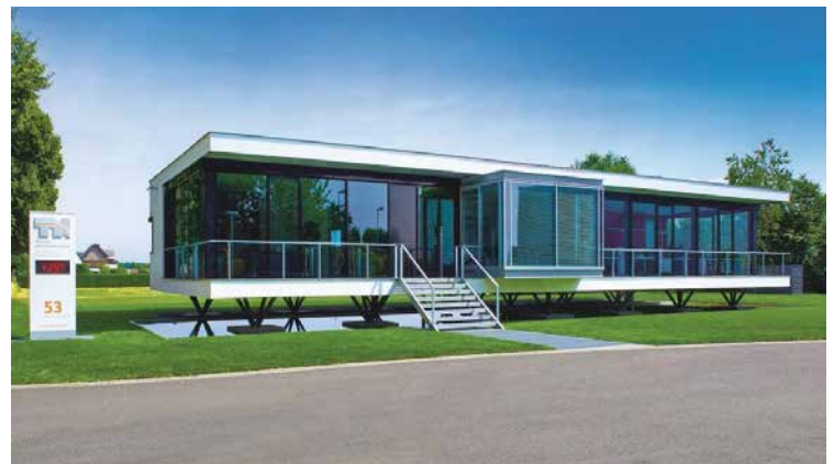
Bürogebäude Tönisen Bedachungs GmbH Goch
