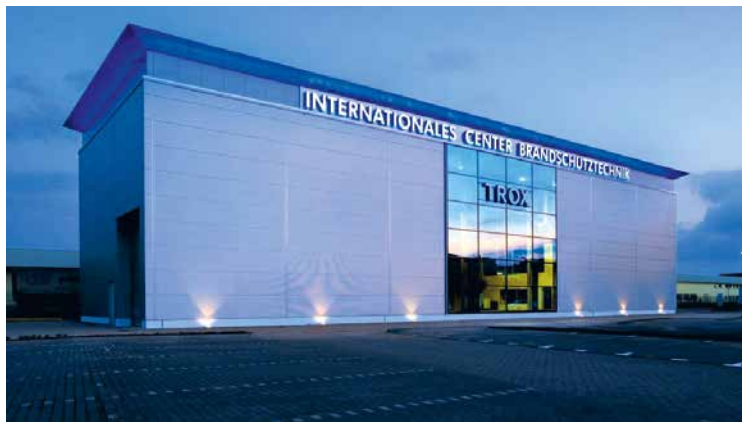
Das Brandschutzcenter Trox in Neukirchen-Vluyn
