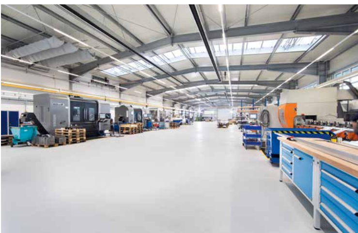
Viel Platz: Innenansicht von Werk II
