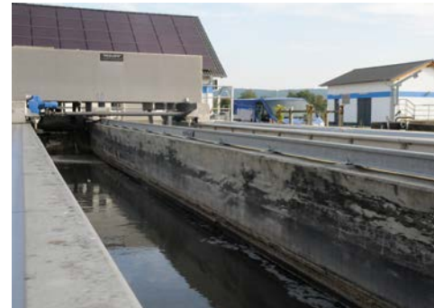
Auch in den Umbau und die Erweiterung der großen Kläranlage wurde investiert
