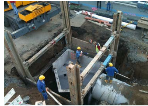
Der Bau eines neuen Schachtes war teil der umfangreichen Kanalbauarbeiten
