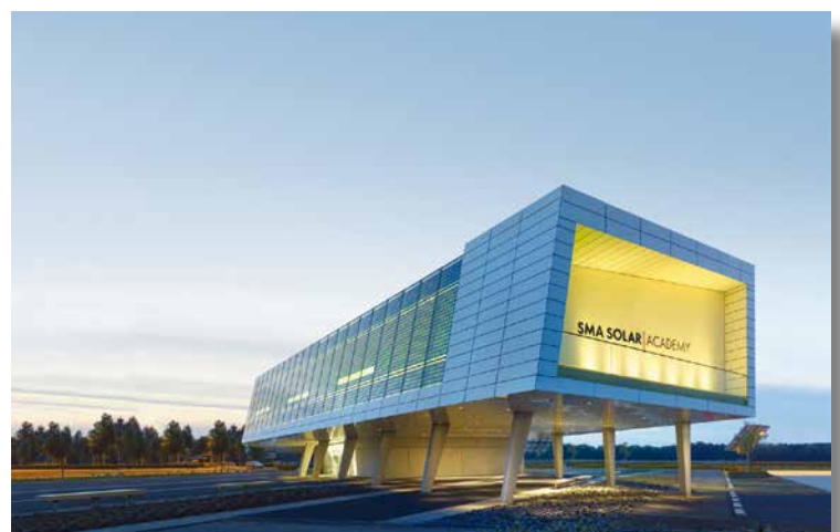
In der SMA Solar Academy wird die Vision von SMA erlebbar: Die zuverlässige, dezentrale Energieversorgung aus erneuerbaren Energien – an jedem Ort der Welt
