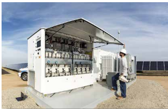
Der Zentral-Wechselrichter Sunny Central wurde speziell für den Einsatz in großen PV-Kraftwerken entwickelt
