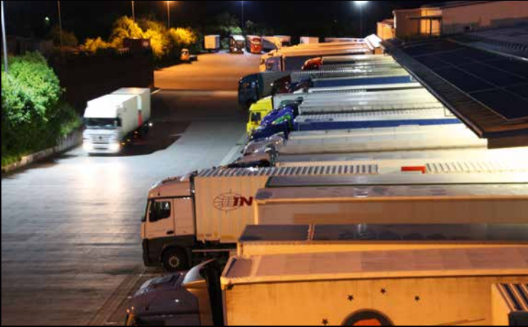
Der Zentral-HUB in Homberg/Efze verfügt über insgesamt 160 Ladetore
