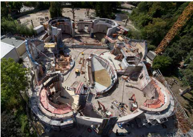
Die ursprünglich geplante Modernisierung der Kuppelkonstruktion des Elefantenheges im Tierpark Hellabrunn führte schließlich zu einer Umstrukturierung des Gebäudes
