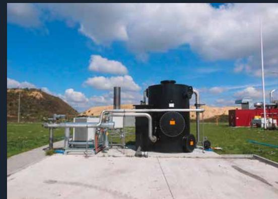
**Mit den eigens dafür entwickelten Pellets der Firma UGN-Umwelttechnik GmbH wird für eine effiziente Entschwefelung von Biogas gesorgt**
