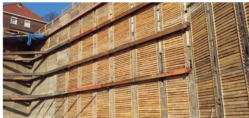
Sichern und Stabilisieren gehört zu den Hauptaufgaben im Spezialtiefbau
