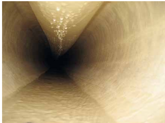
SOLTA®LINER XTRA 2 in 1: Es entstehen zwei neue Rohre im zu sanierenden Kanal, etwa für die zusätzliche Integration von Kommunikationsnetzen
