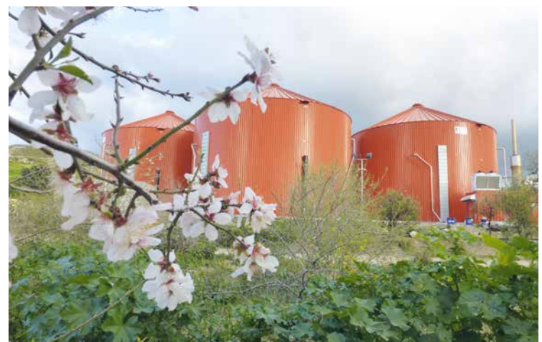
Eine Biogasanlage der LIPP GmbH
