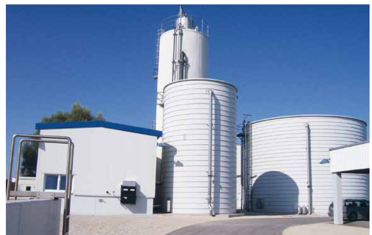
Die LIPP GmbH bringt sowohl Flüssigkeits- als auch Pufferbehälter zum Einsatz
