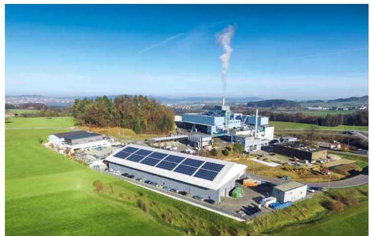
Thermische Verwertung in der Schweiz: Anlage des Zweckverbands Abfallverwertung Bazenheid
