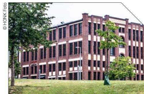
© HONK Foto Die Niederlassung in Bad Hersfeld in Hessen wurde 2019 eröffnet
