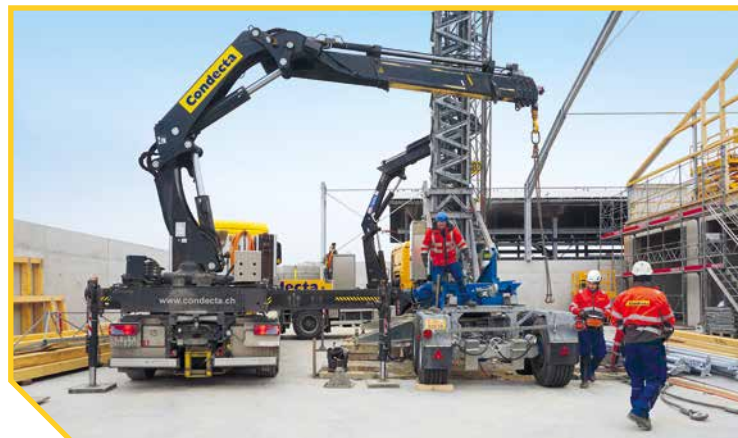
Conducta-Kräne haben sich vielfach im rauen Baustelleneinsatz bewährt und sind in vielen verschiedenen Ausführungen erhältlich, hier bei der Montage
