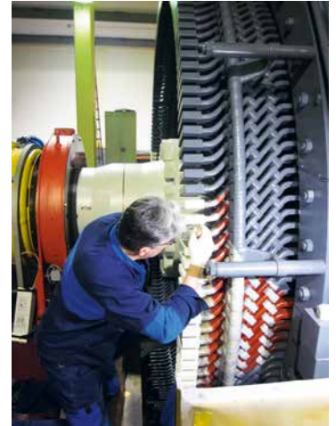
Blick auf Revisionsarbeiten in einem Kraftwerk
