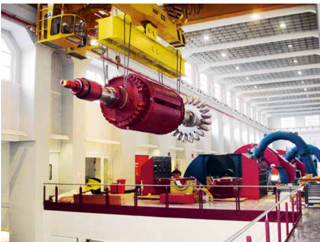
Montage eines Rotors in einem Kraftwerk
