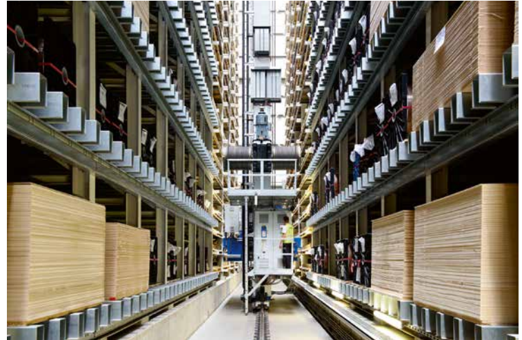
Holzlager heute: Eine komplexe und vollautomatisierte Anlage
