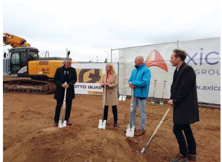
Spatenstich für einen Neubau bei Frankfurt für den Ausbau des Parallelimportgeschäfts der Tochtergesellschaft axicorp
