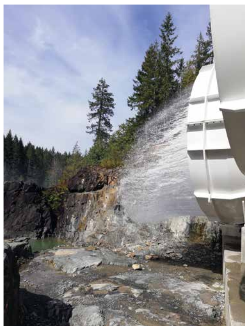
Kegelstrahlschieber 'John Hart' beim Öffnen
