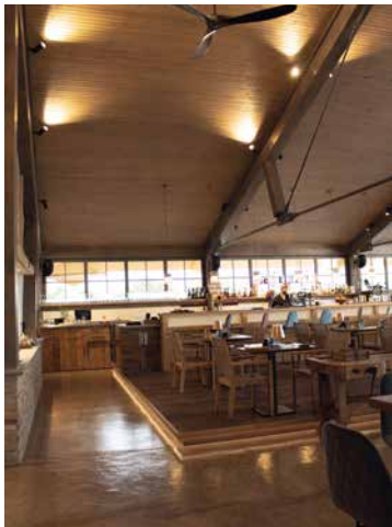
Gedübelt statt geleimt: Dübelholzelemente werden für Wände und Decken verwendet
