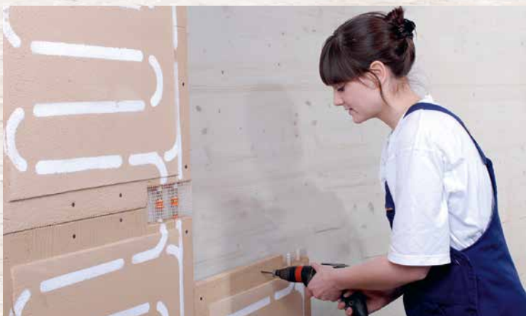
Hier das Highlight: Das Rohr ist schon in der Platte integriert
