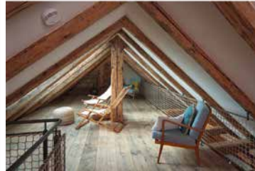
Reguliert die Feuchtigkeit: Lehmputz im Loft
