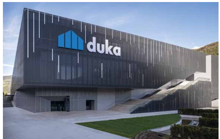
Headquarter Duka AG – Heizen und Kühlen durch Betonkernaktivierung
