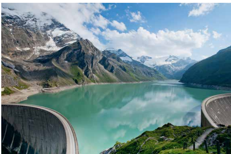
Pumpspeicherkraftwerk inmitten der Alpen
