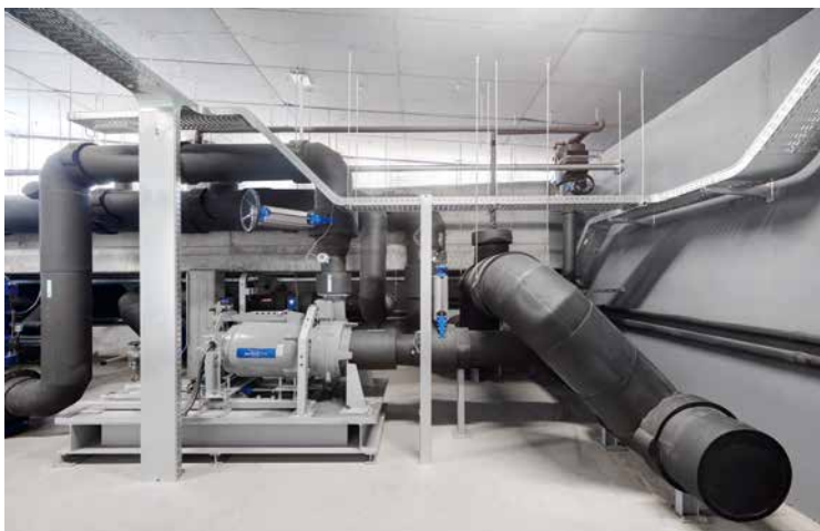
Zentrale der Flusswasserkühlung für die Unternehmen Alupress, Duka, Progress und Mikrotec
