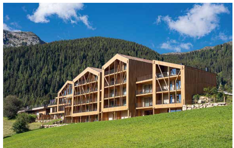
Neubau vom Hotel Gassenhof – Kunde seit über 30 Jahren
