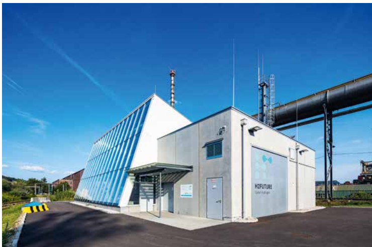
Gemeinsam mit voestalpine ist in Linz eine der größten Elektrolyseanlagen errichtet worden
