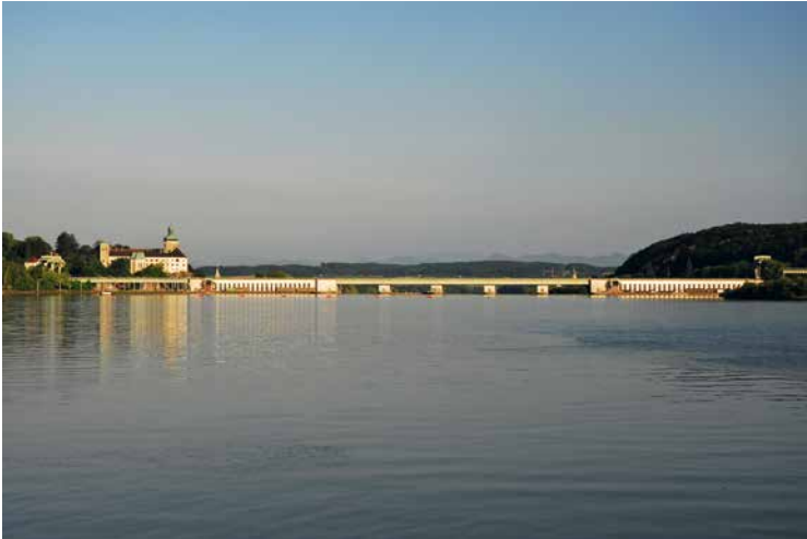
Verbund Energy4Business vermarktet den Strom aus 131 Wasserkraftwerken in Österreich; hier Ybbs-Persenbeug an der Donau
